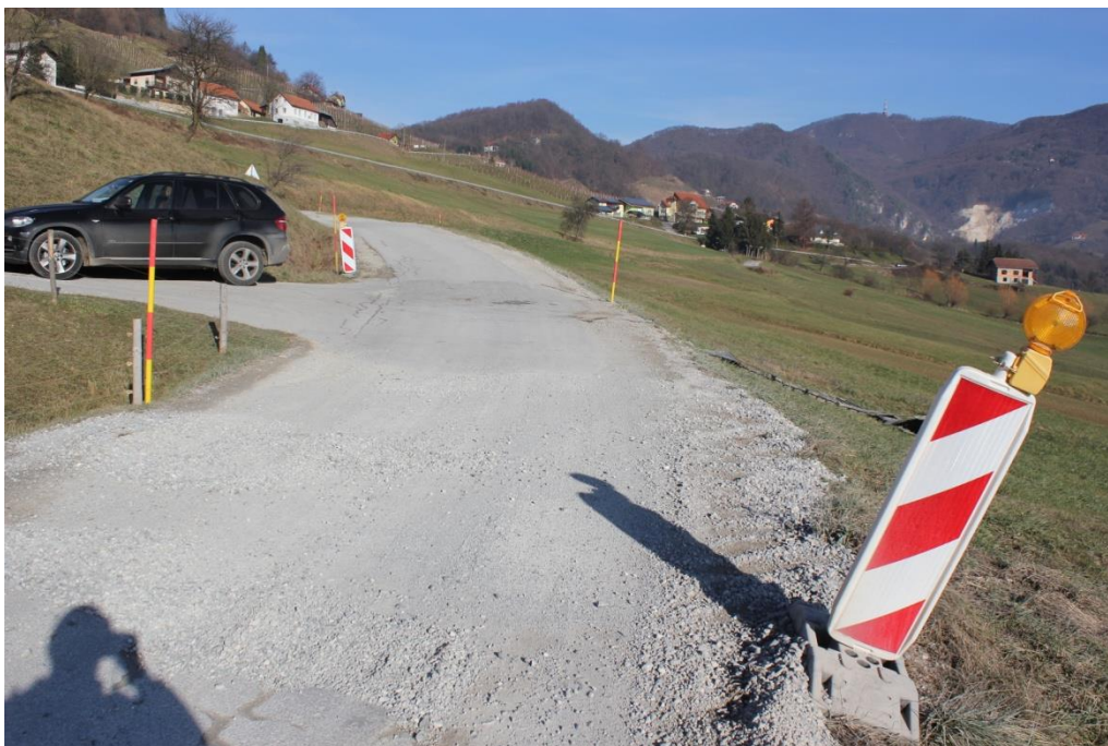
Na sliki viden premik ceste v prečni smeri za cca 15cm, v vertikalni pa cca 30cm
